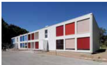
Während der Sanierung des Bläsi-Schulhauses wird in temporären Klassenräumen unterrichtet. Bild BVD
